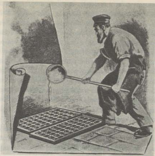
Wylanie w formy roztopionego metalu przy odlewnictwie sposobem rzemieślniczym (wg: A. Herdan. O odlewie liter . Warszawa 1907, zbiory BUW)
